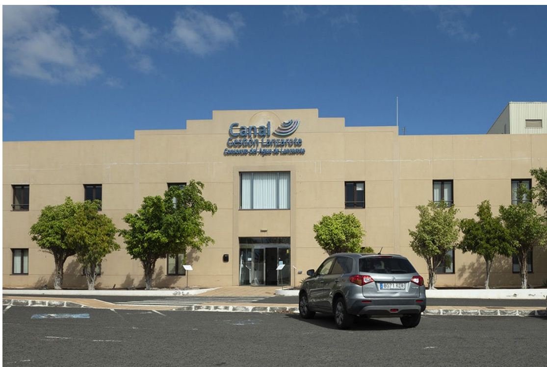
Oficinas de Canal Gestión en la central de desalación Díaz Rijo. Foto: Adriel Perdomo.
